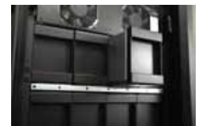
75kW机种可选配热拔插电池模块
